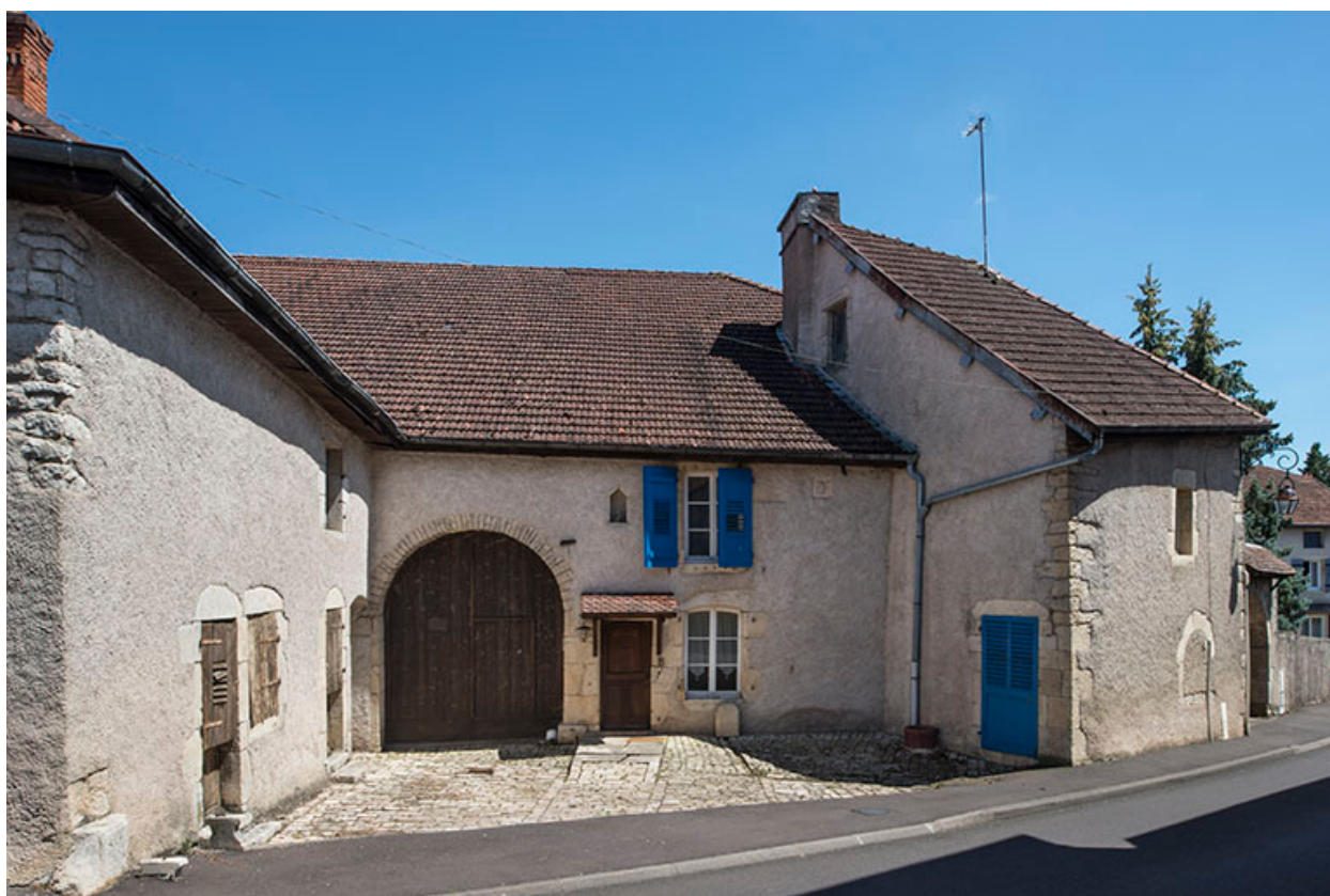
La façade antérieure et la cour.
