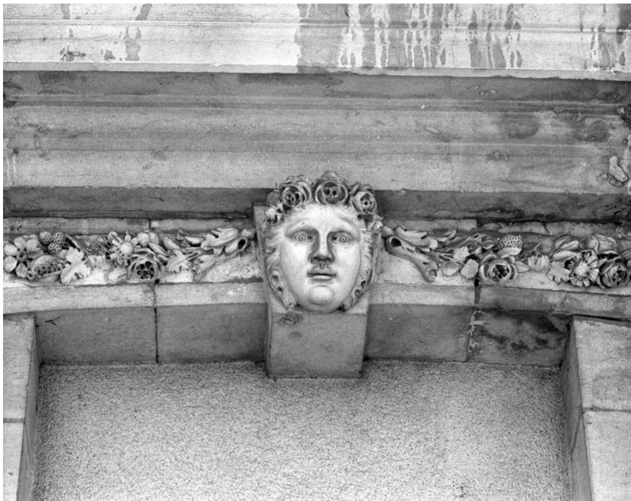
Détail : décor du mur d'enclos.
