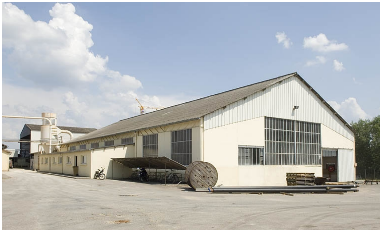
Atelier de fabrication (moulures).
