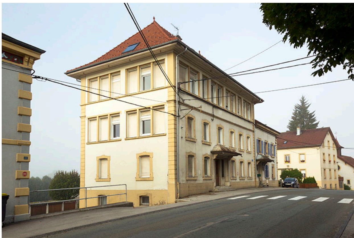
Vue d'ensemble depuis l'est (façade antérieure).
