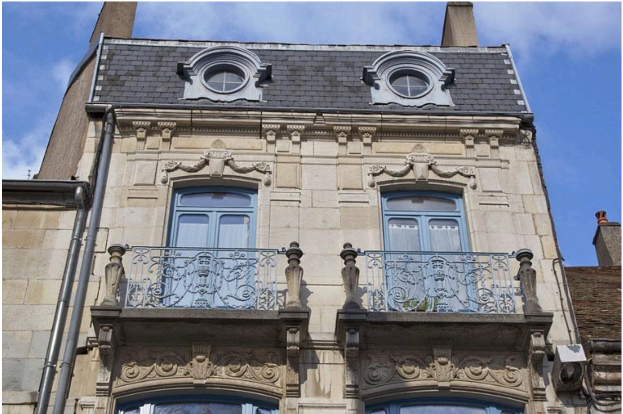
Deuxième logis secondaire, façade sur rue : vue du deuxième étage, de face.
