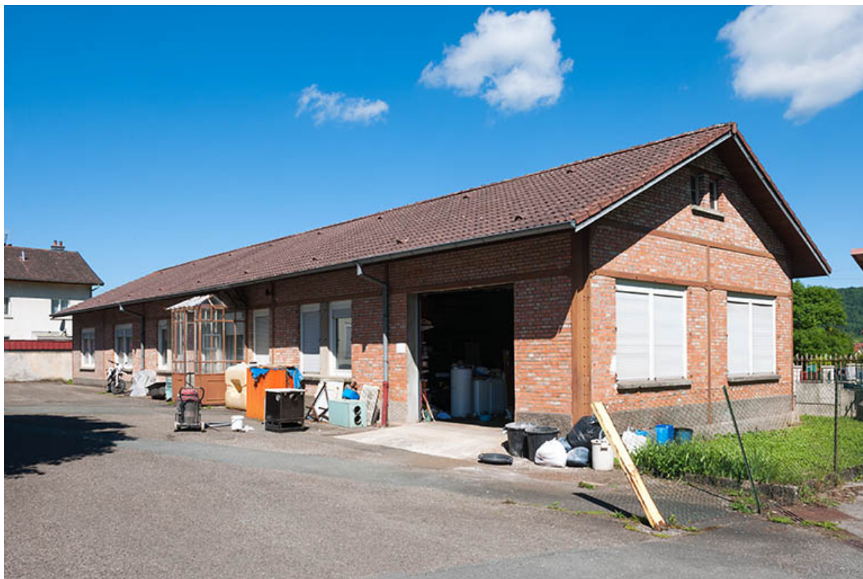
Logements et bureau vus de trois quarts.
