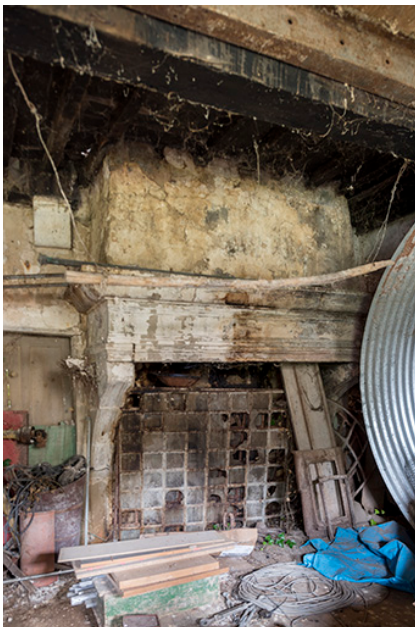
Cheminée adossée, au rez-de-chaussée de l'ancien logis.
