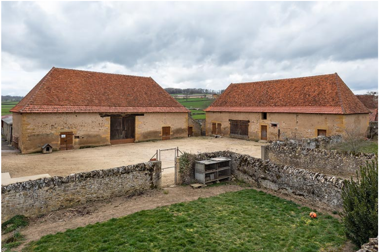
Vue de la grange, à l'ouest, et de la seconde dépendance, au nord de la cour
