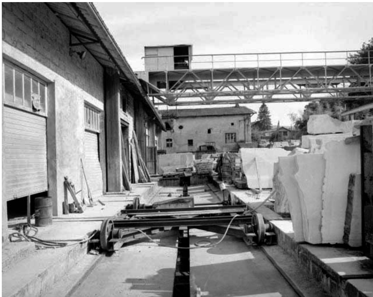
Chariot desservant l'atelier de fabrication.
