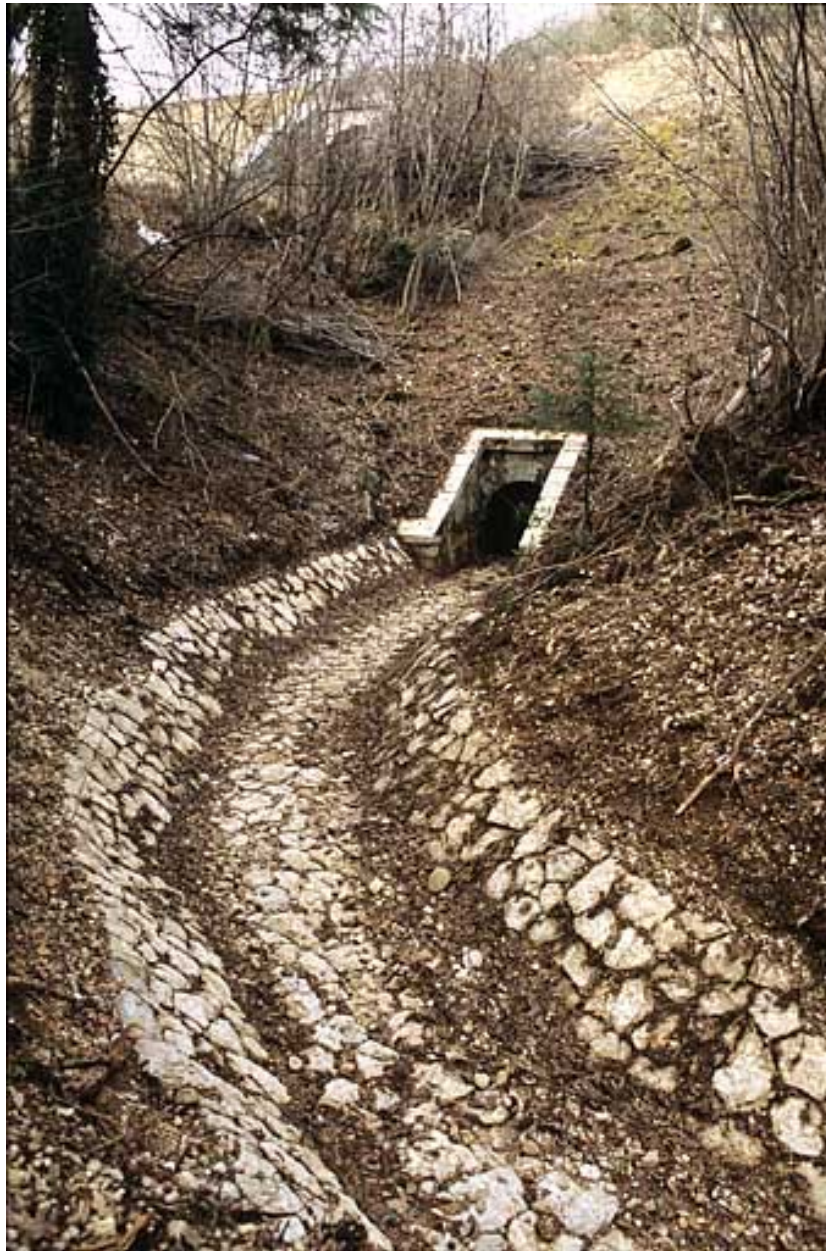
Aqueduc : tête aval (ouest) et rigole.
