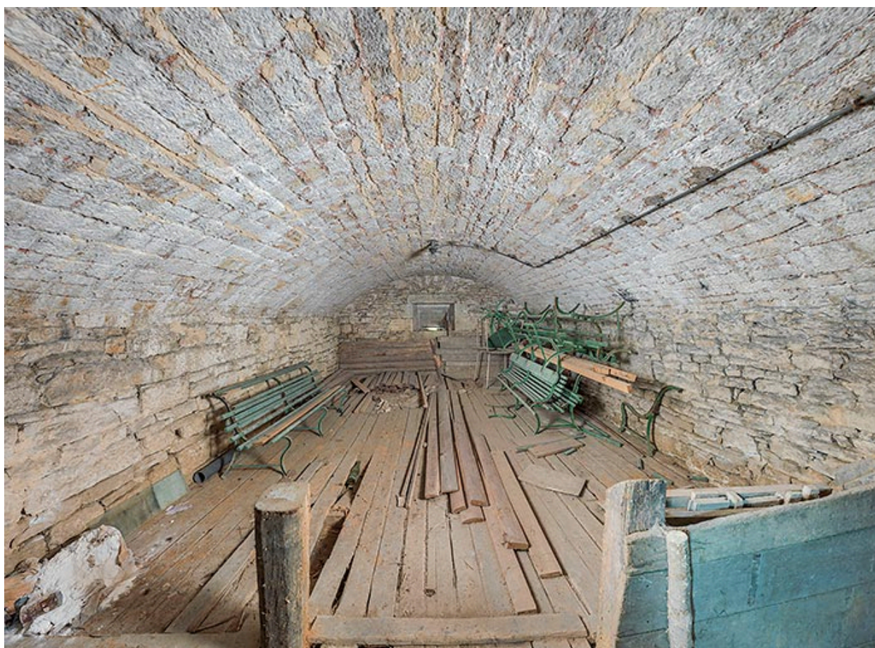
Casemate et sa voûte à l'épreuve.
