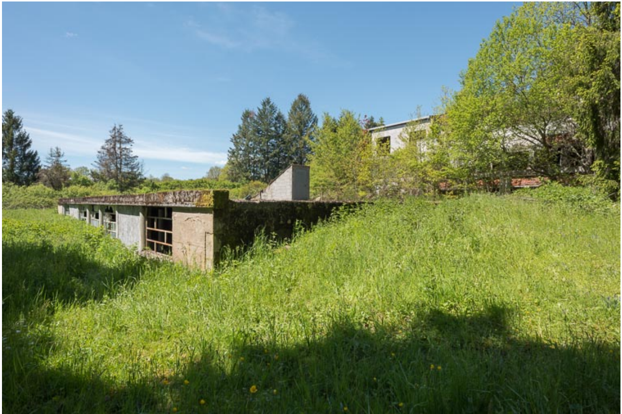
Aménagement du captage de la source, vue extérieure de trois-quarts.
