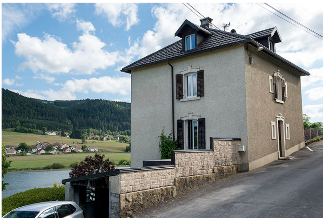
Façades antérieure et latérale gauche.
