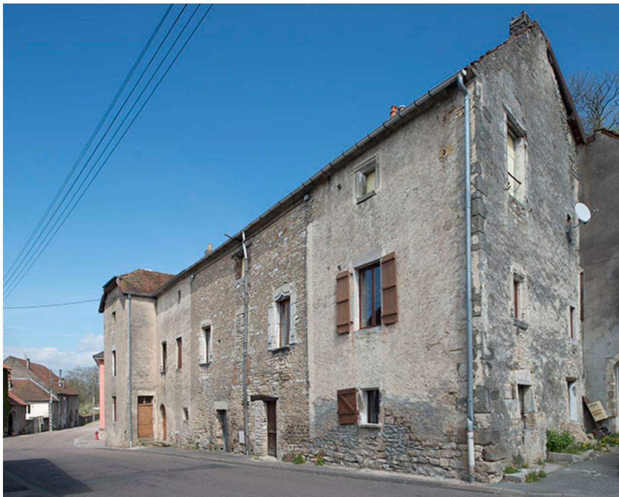
Vue générale de l'édifice depuis le sud.
