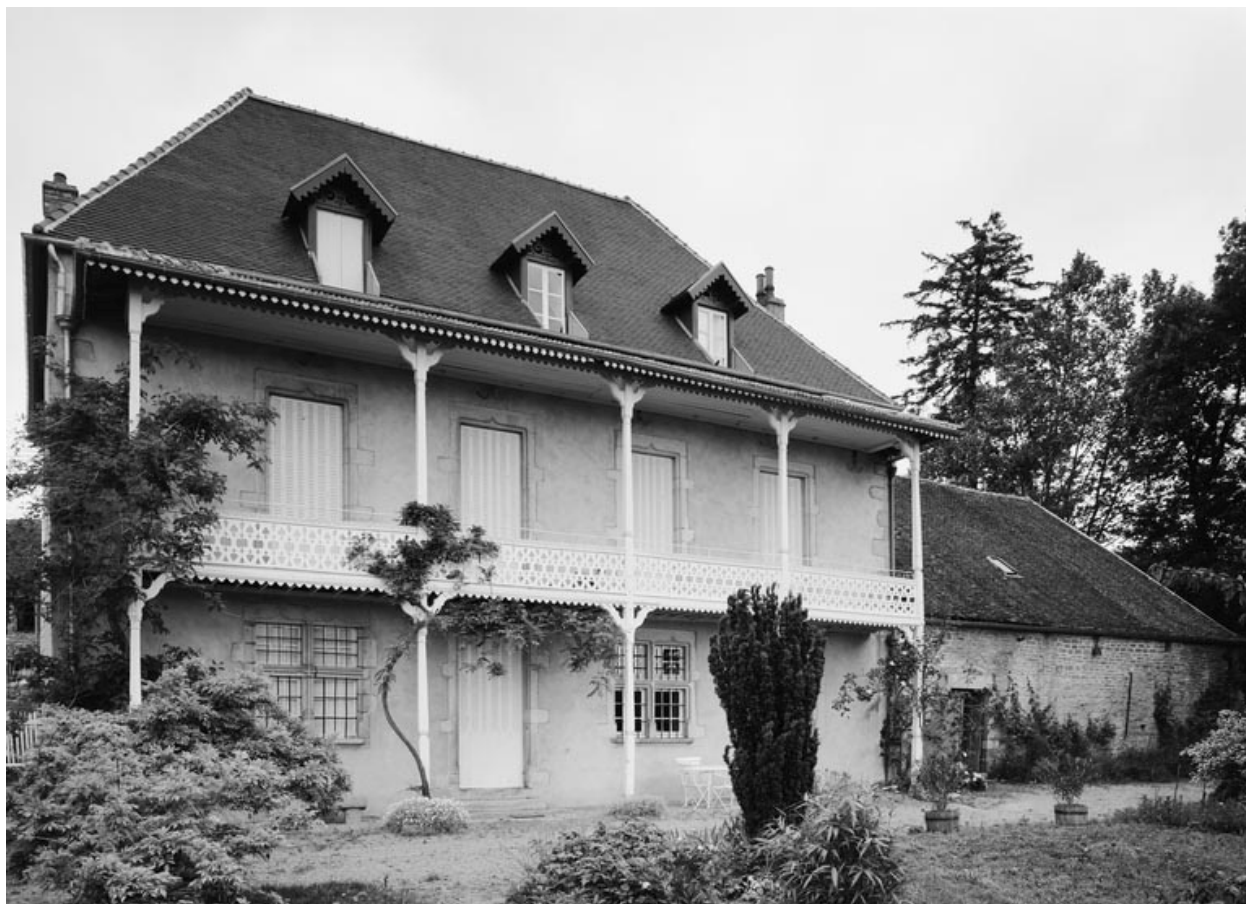
Logis et cuverie.
