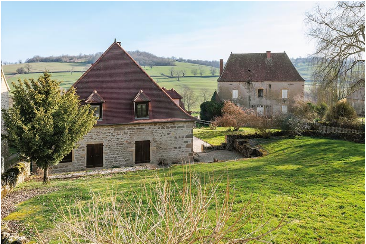
Ancienne ferme d'embouche, construite à la fin du XVIIIe siècle par la famille Mommessin
