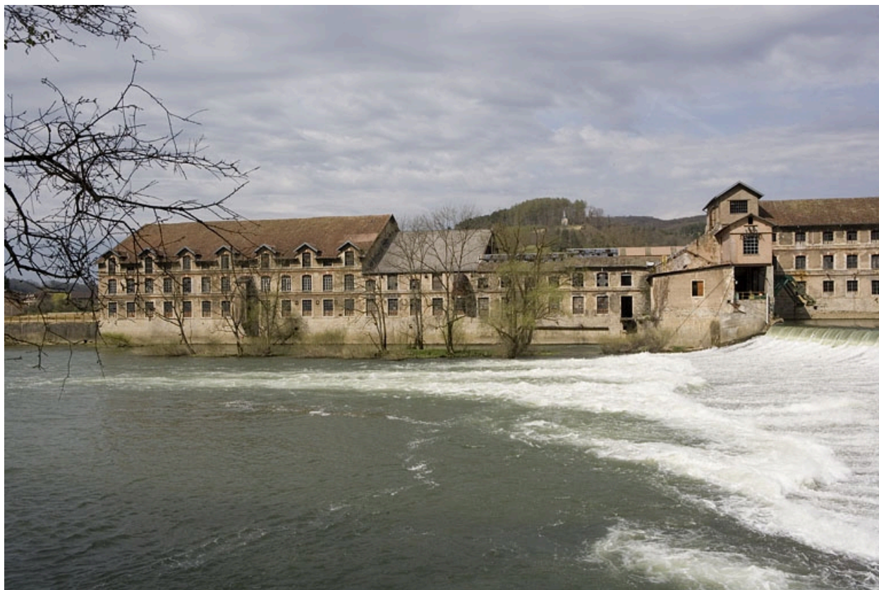
Façade est de l'atelier de la machine à papier.
