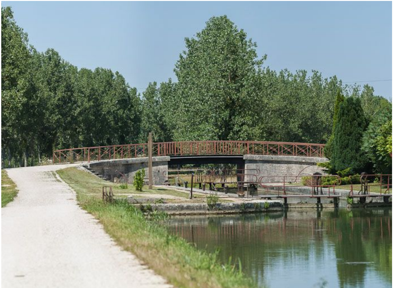
Le pont vu d'amont.
