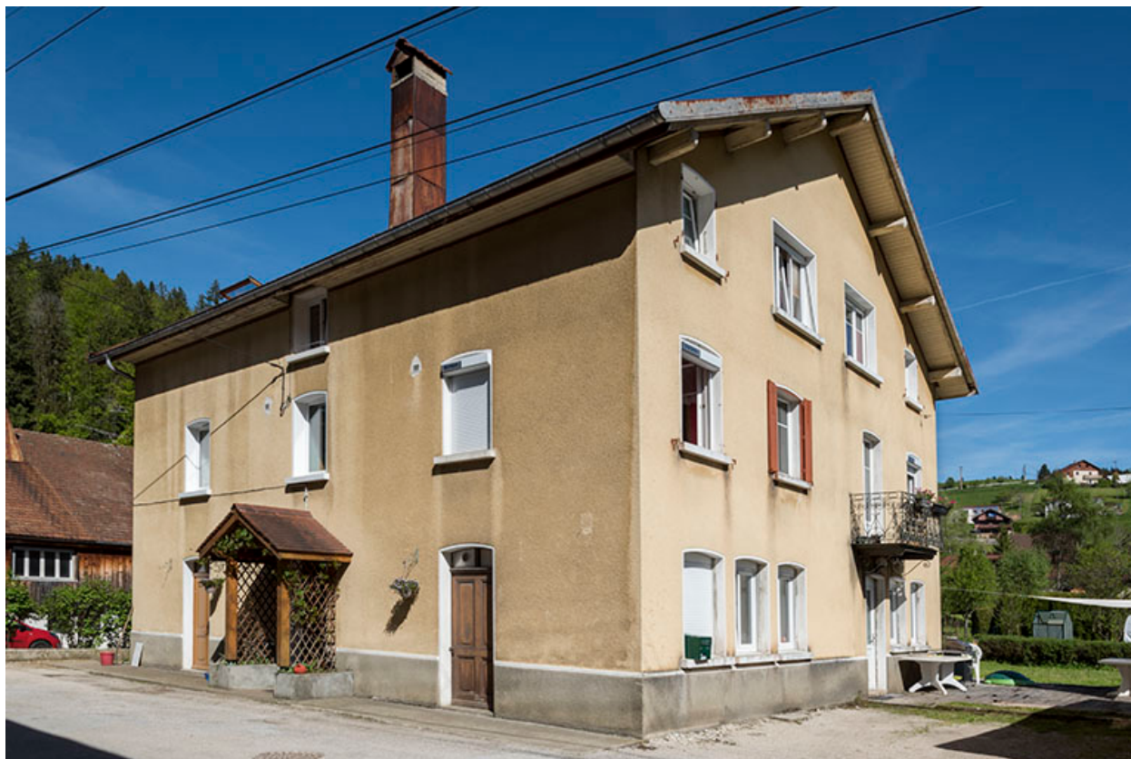
Fonderie : façades antérieure et latérale droite.
