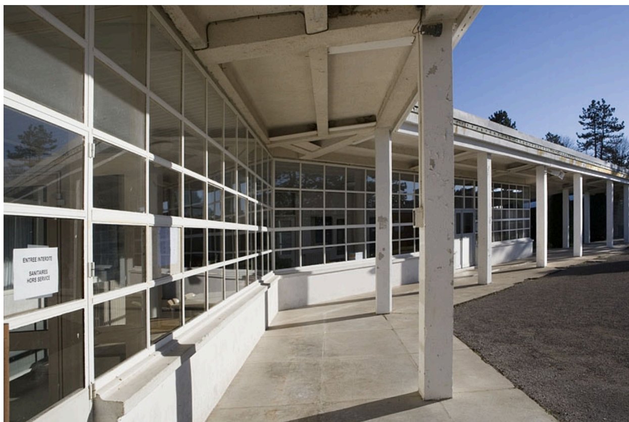
Façade de l'externat : détail
