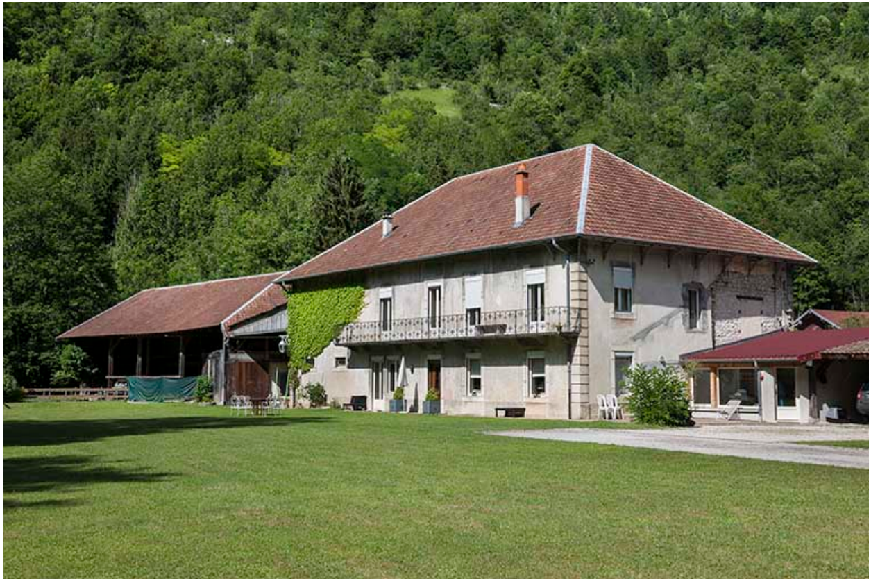
Logement patronal vu de trois quarts droite.
