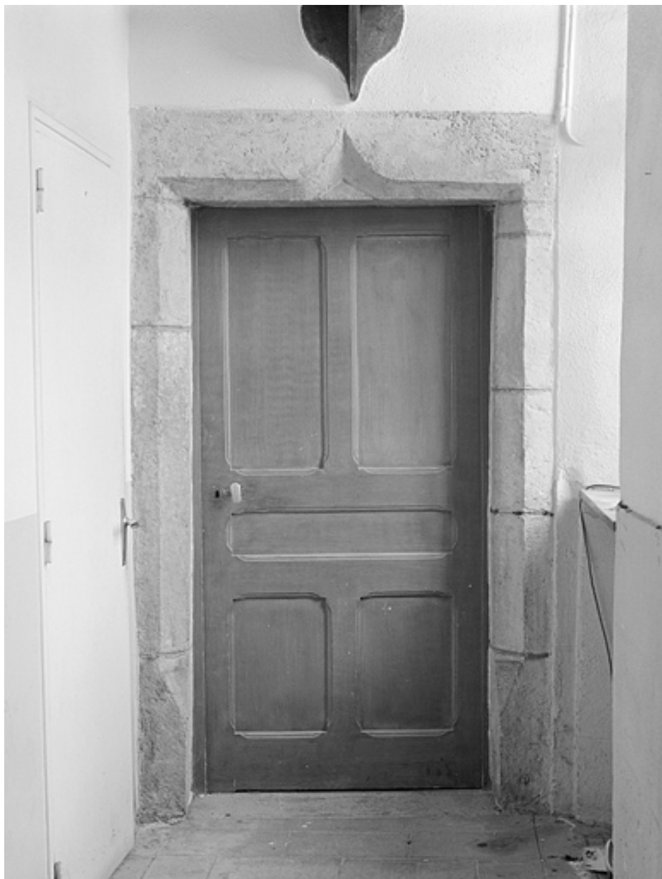
Porte intérieure avec linteau en accolade.
