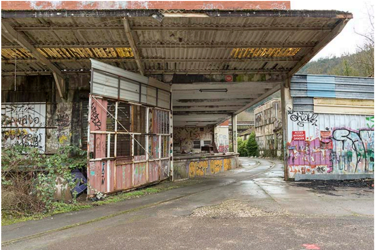
Etat en 2016. Usine A : portail à la jonction de la cantine (T) et de l'étirage tergal (S).
