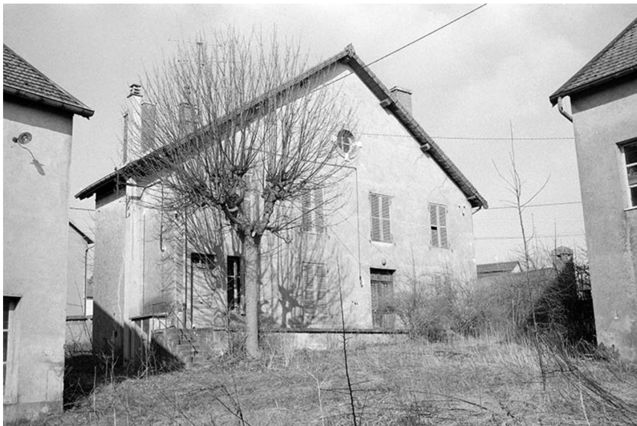
Façade antérieure du bureau vue de l'est.
