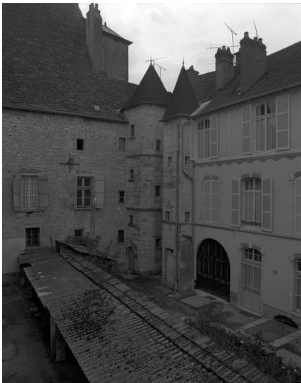
Façade latérale gauche : partie droite.
