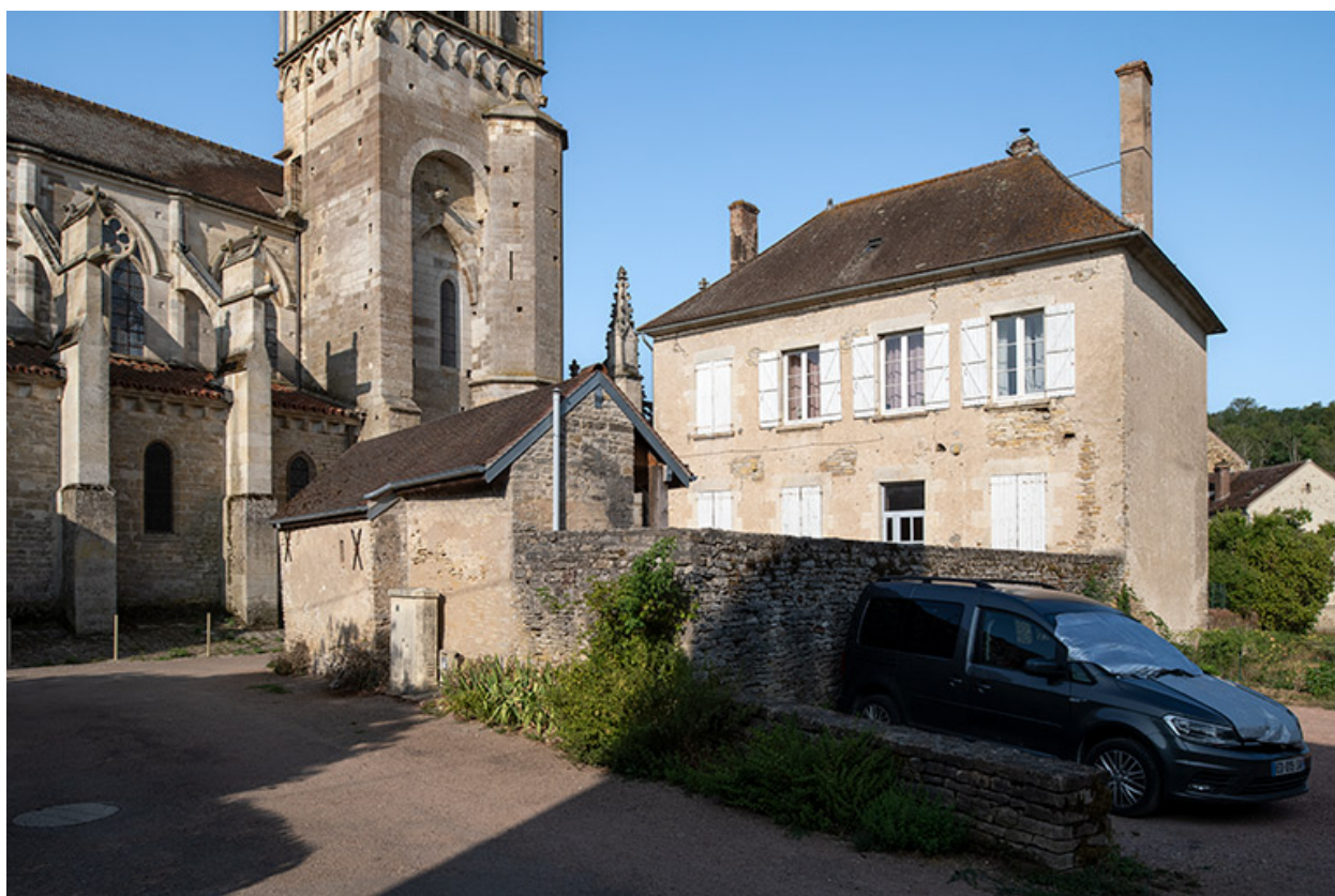
Façade postérieure depuis la rue de la Brèche.
