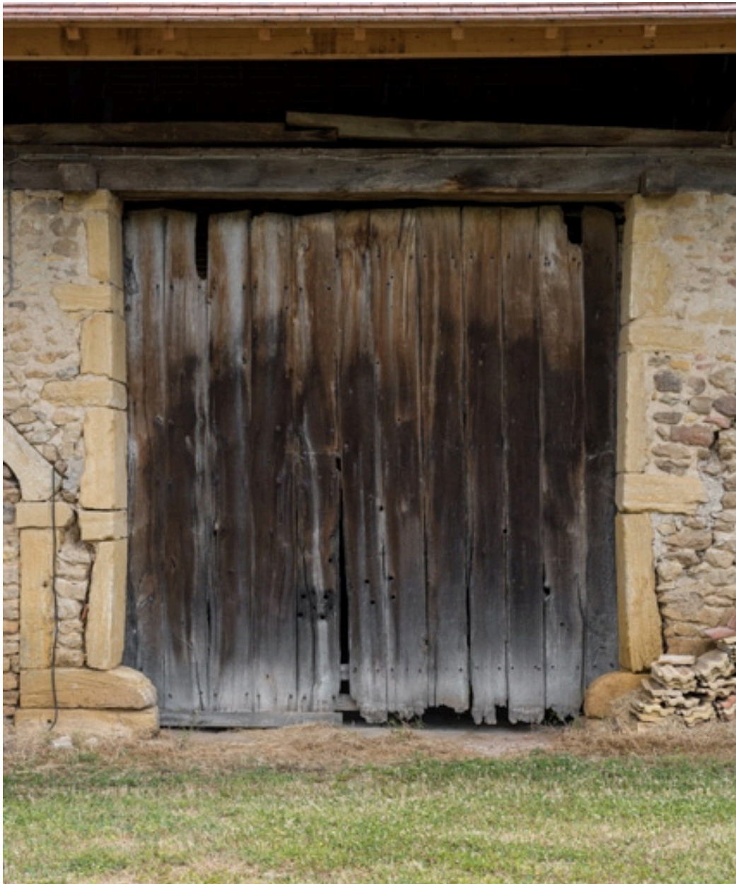
Détail de la façade antérieure de la grange : porte charretière de la remise
