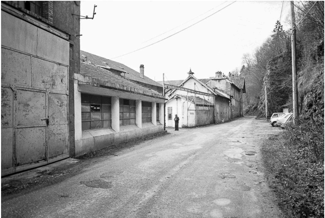
Alignement de façades sur la route d'accès en 1979.
