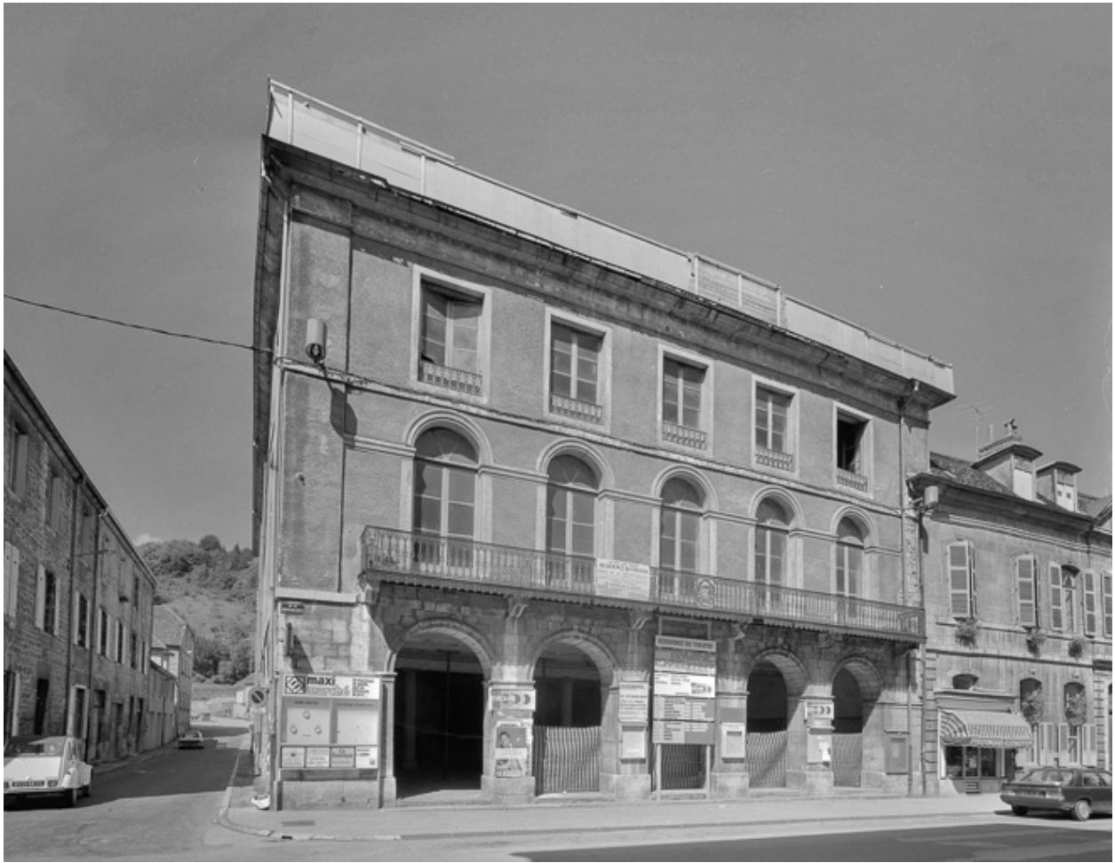
Vue de la façade est avant déconstruction (1987).
