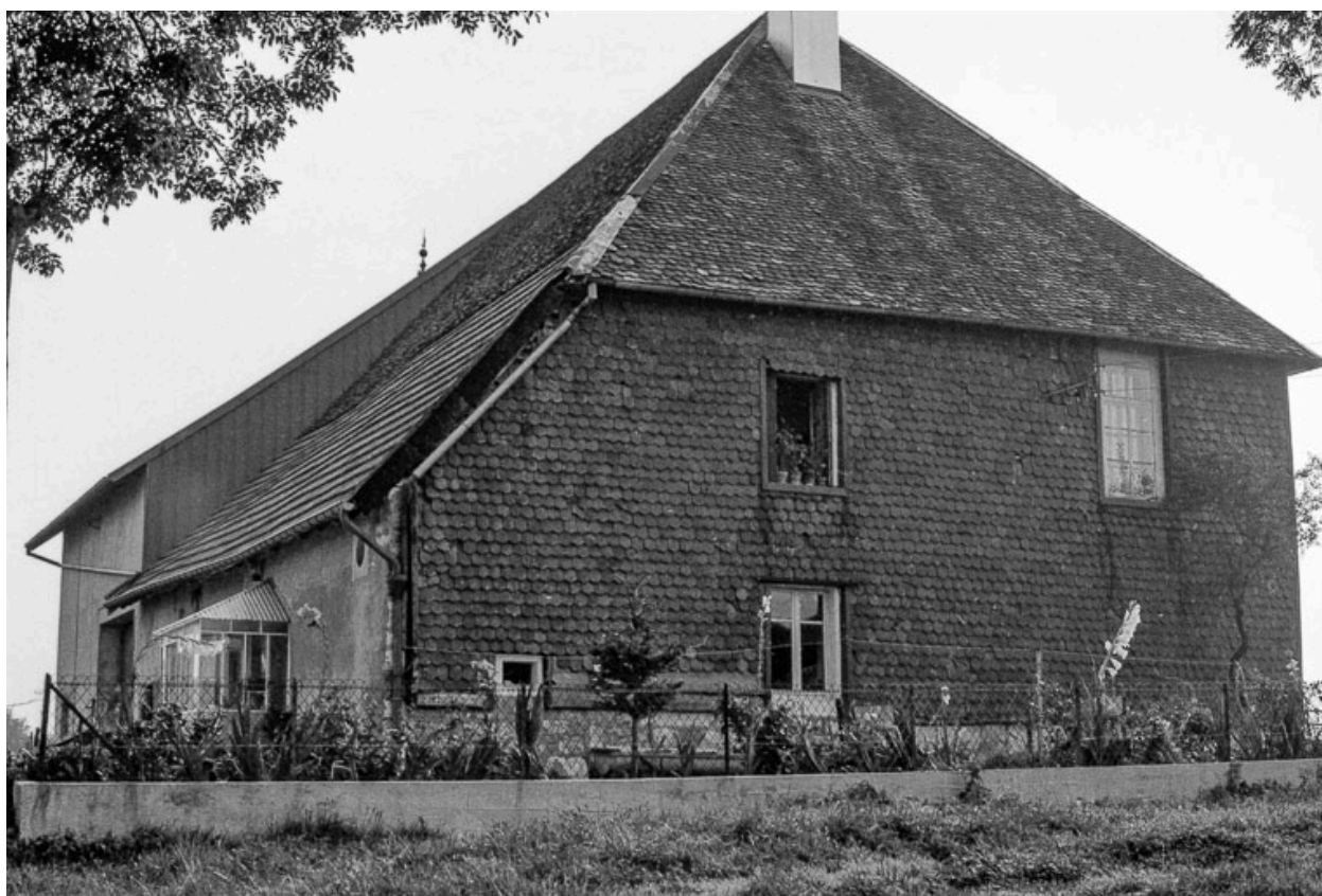
Ferme : façades antérieure et latérale droite.
