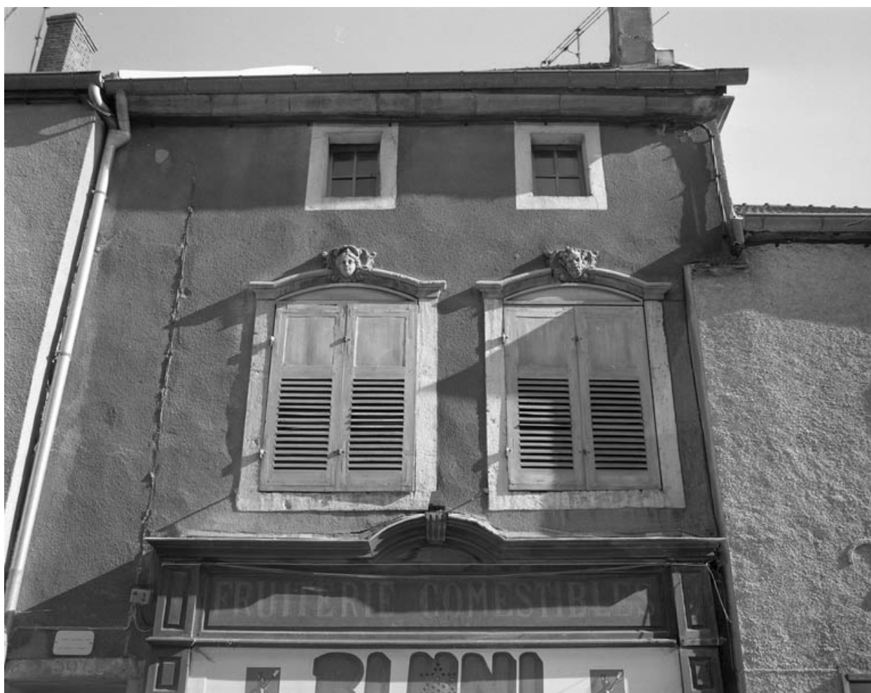
Façade antérieure : détail de la partie supérieure.
