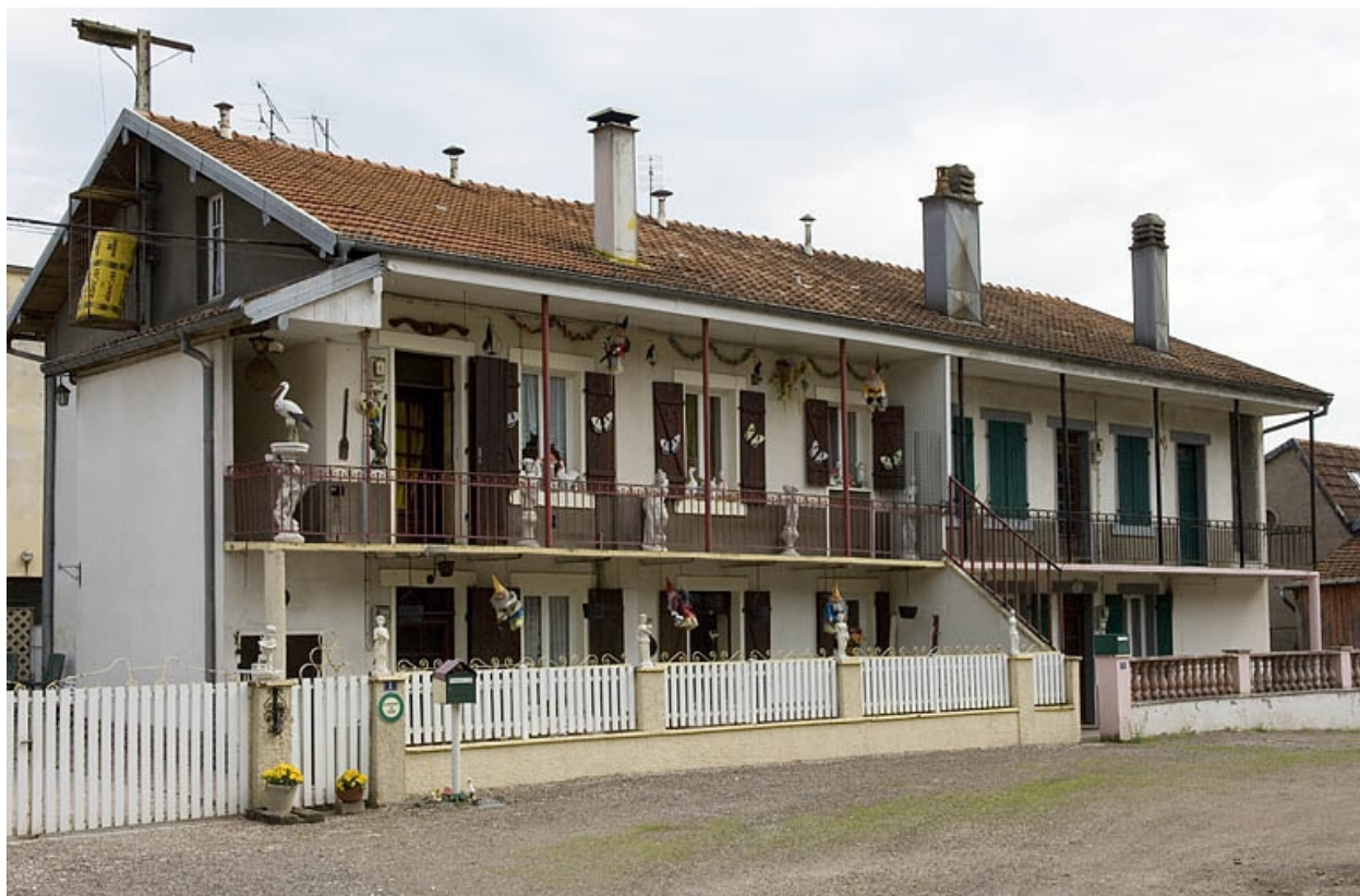
Logement ouvrier à étage (est).
