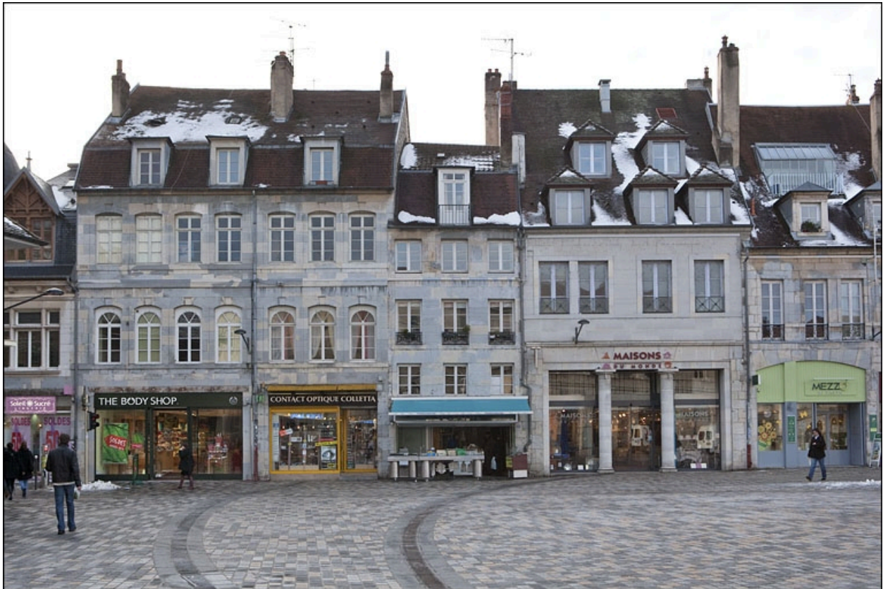
Vue d'ensemble de la façade antérieure, de face.
