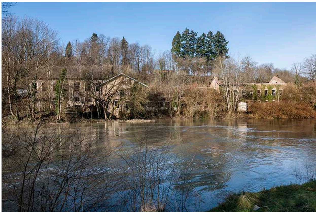
Vue d'ensemble depuis la rive droite.
