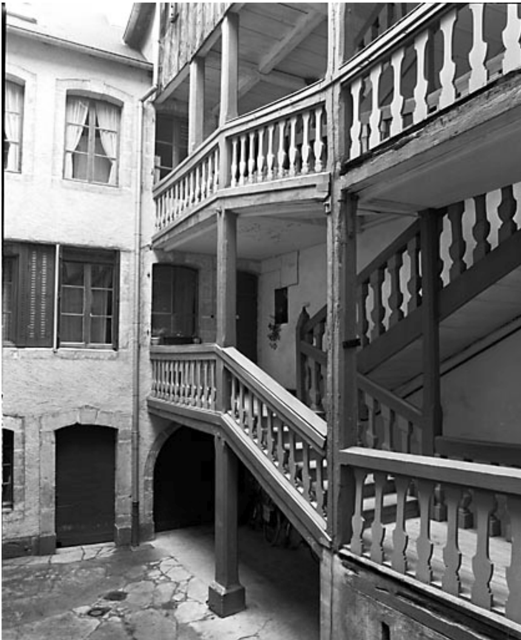
Escalier sur cour intérieure.
