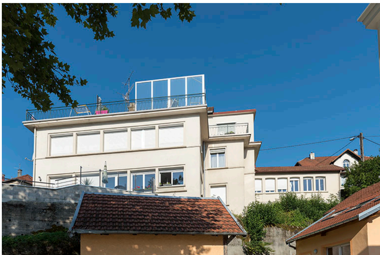
Façade postérieure, vue en contre-plongée.
