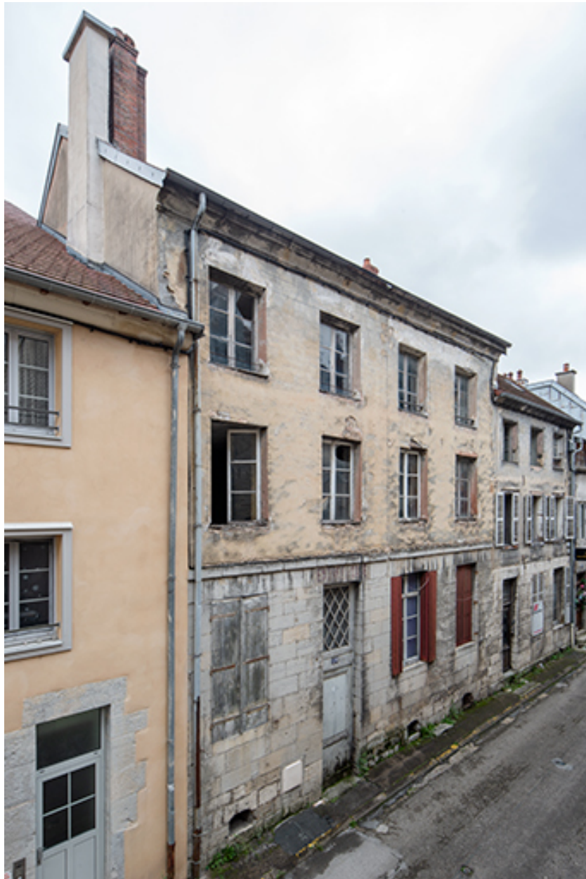
Façade postérieure vue de trois quarts gauche.
