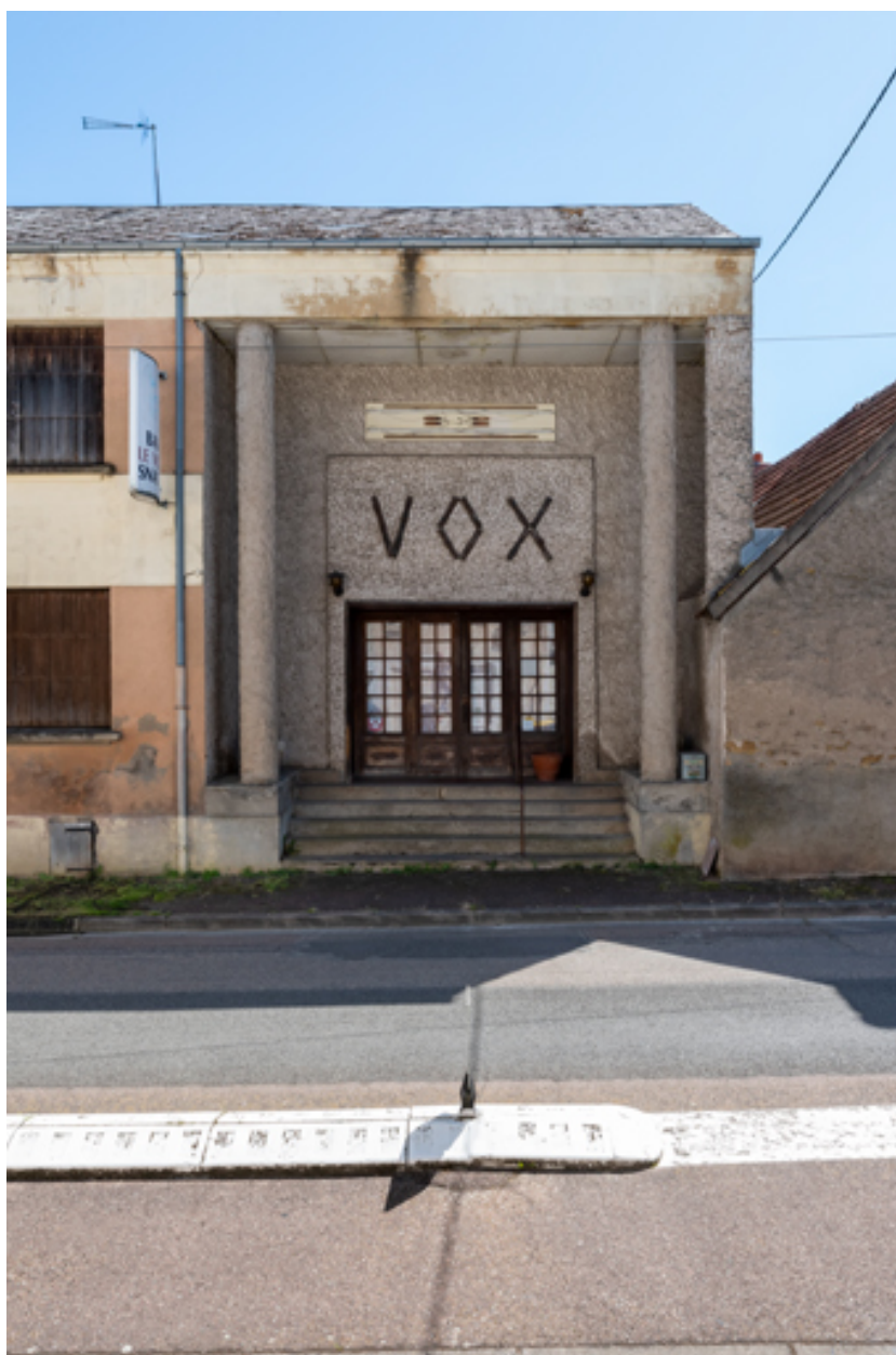
Façade antérieure : entrée avec enseigne.
