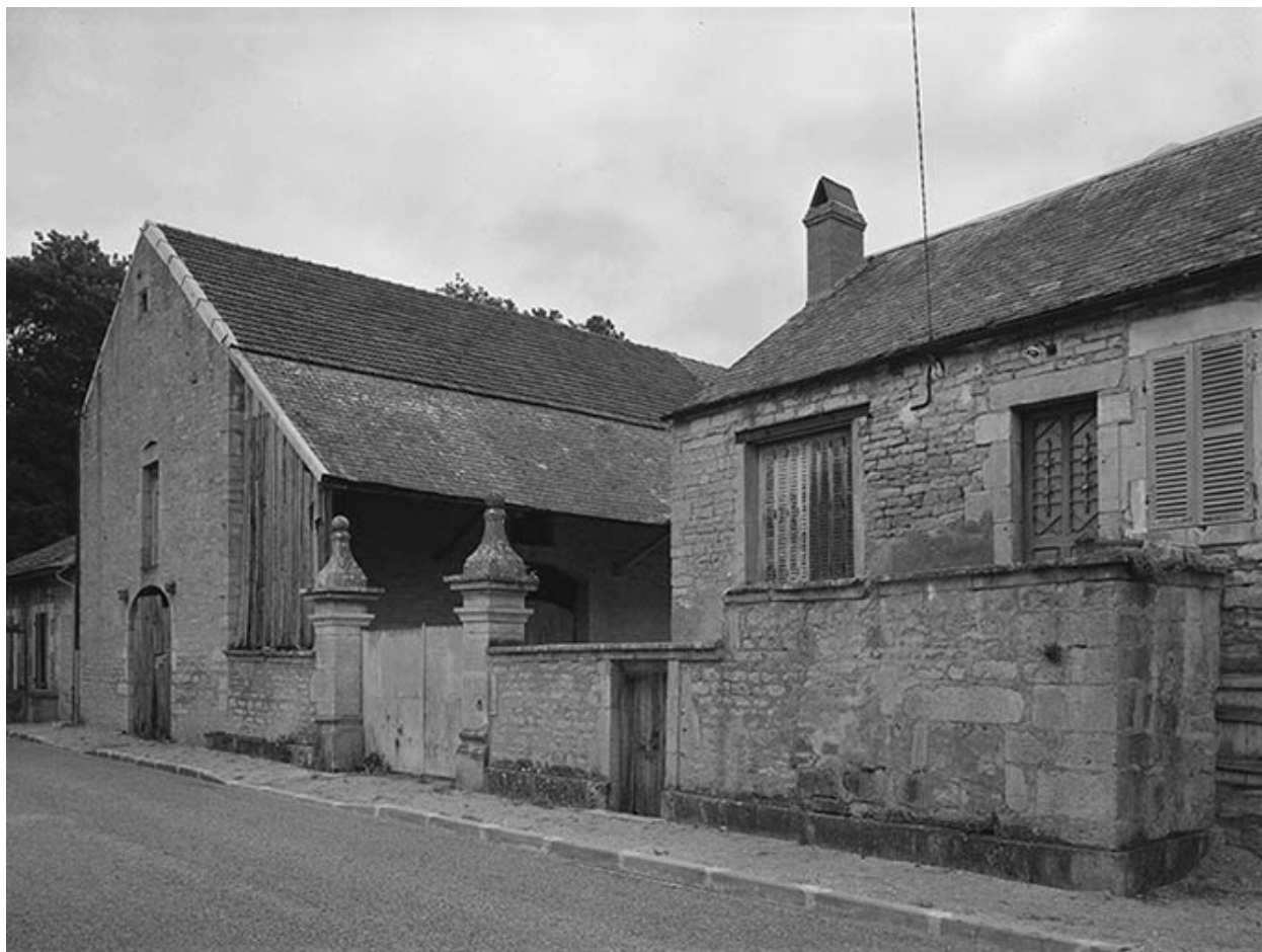
Dépendances, portail et logis. Façades sur rue.
