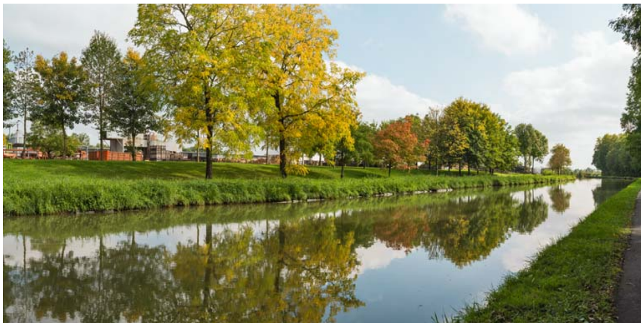
Vue d'ensemble de la scierie et du canal.
