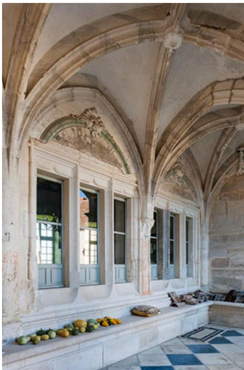
Baies situées au fond de la galerie
