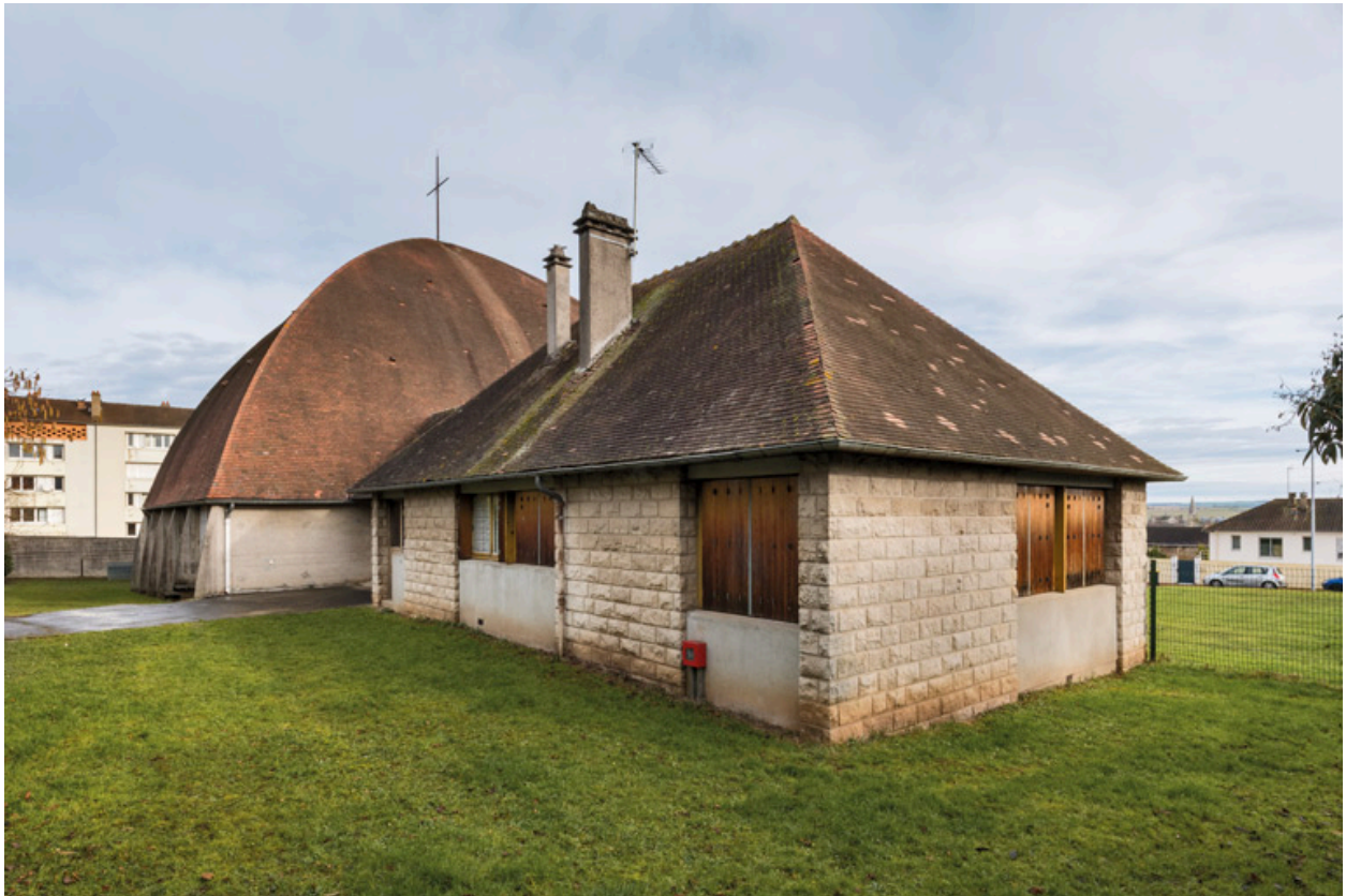
Centre paroissial. Vue de trois-quarts depuis le sud-ouest. Au premier plan, le presbytère.
