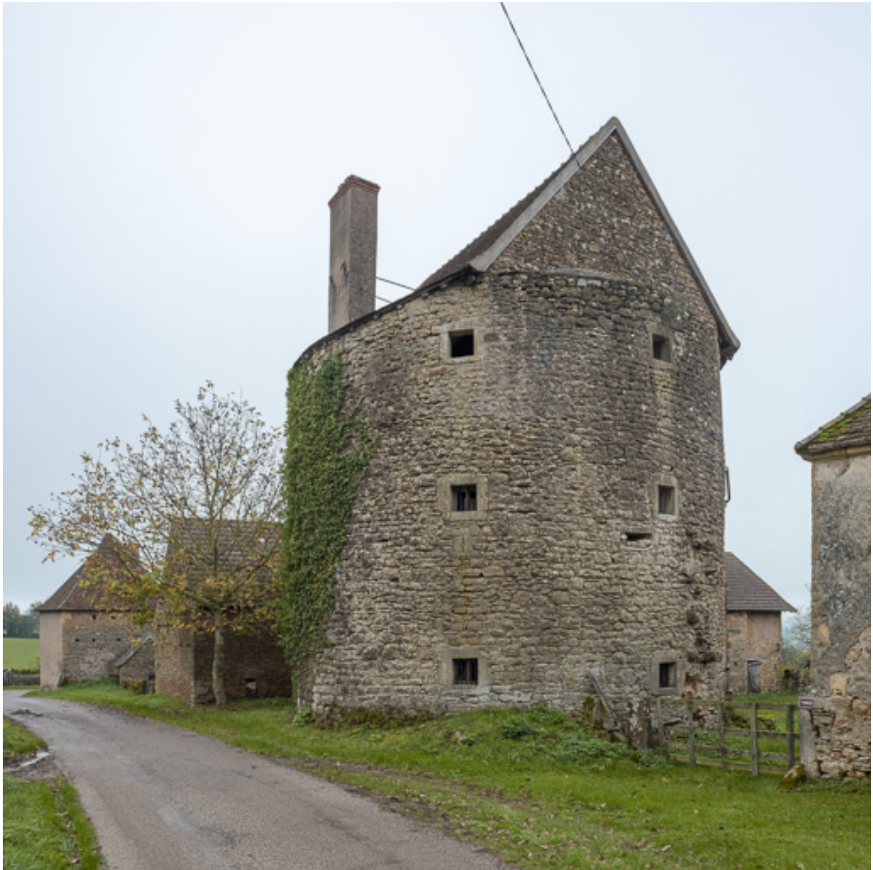
Vue de la tour de Chassagne et des bâtiments de ferme environnants au nord-ouest, depuis la voie communale n°3
