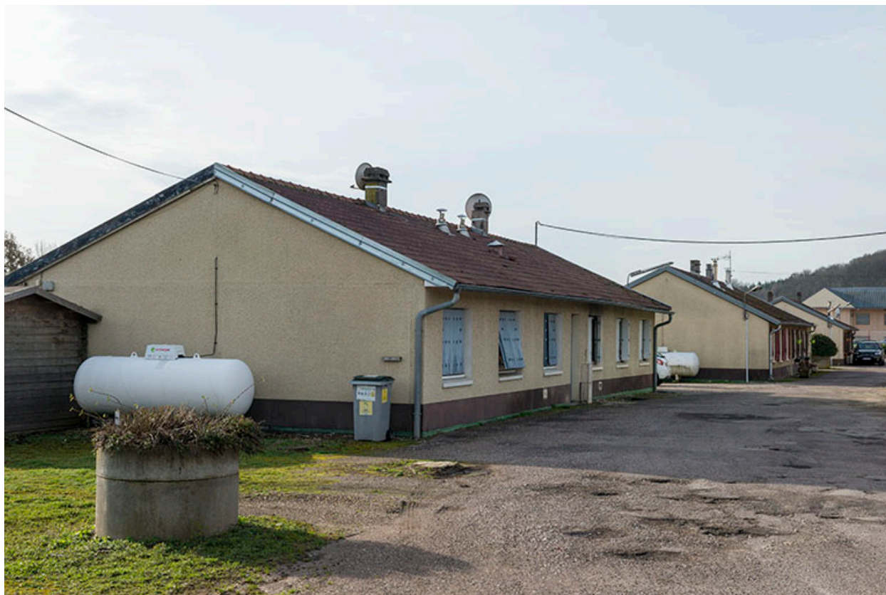
Bâtiment servant de cantine et logement.
