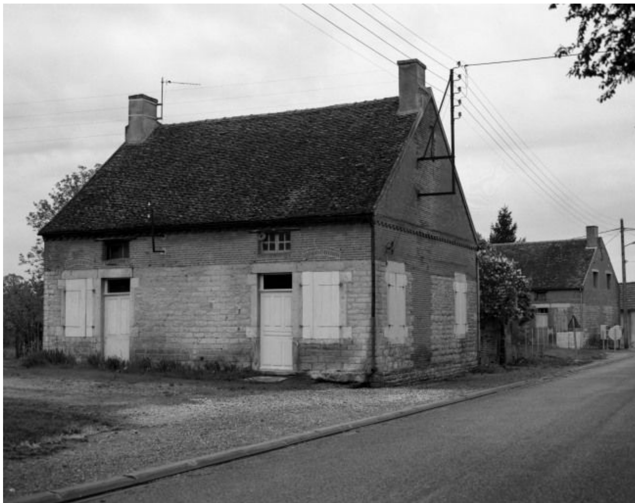
Vue d'ensemble d'une maison (cad. 1985, sect. AB, parc. 237).
