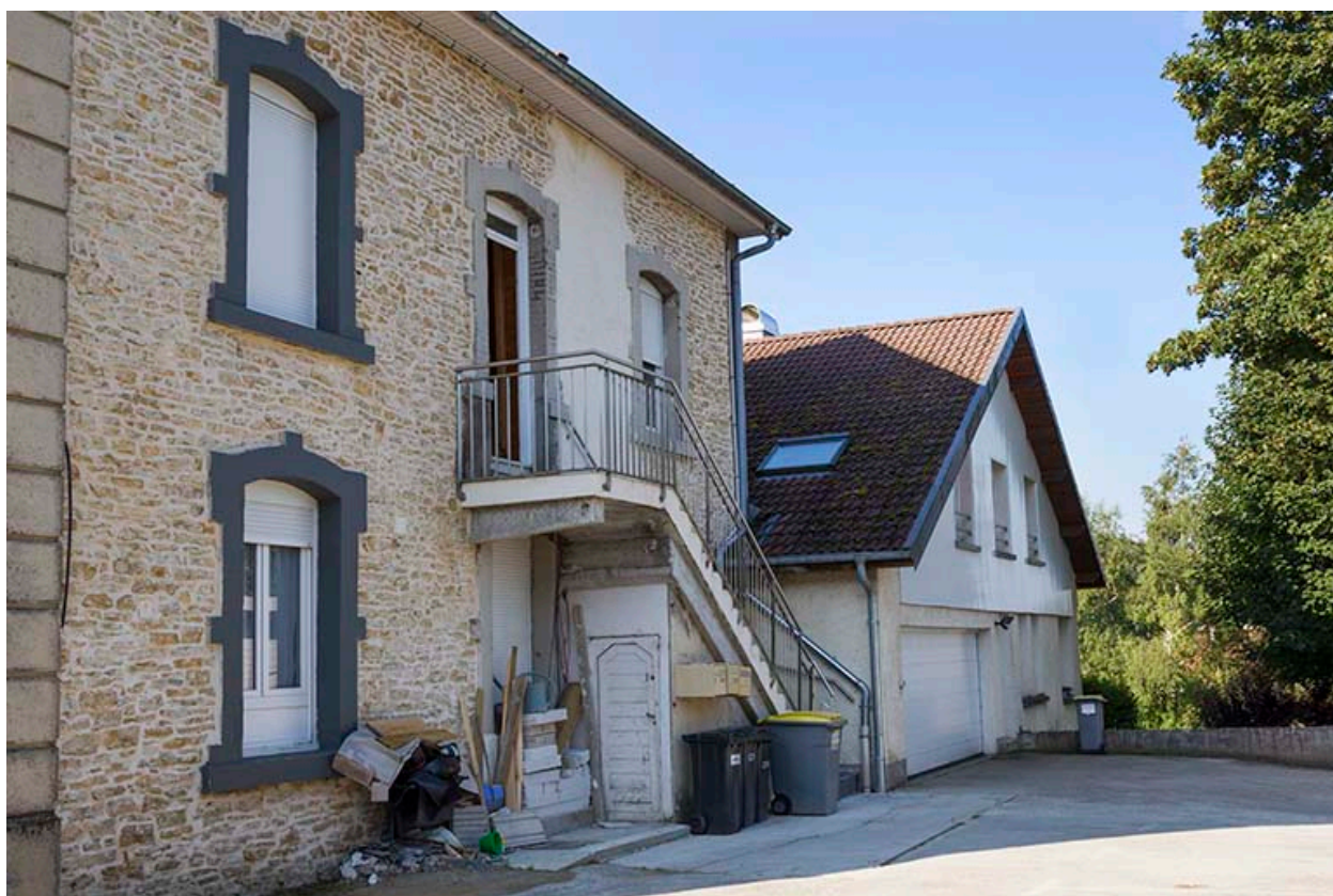
Logement : façade latérale droite.
