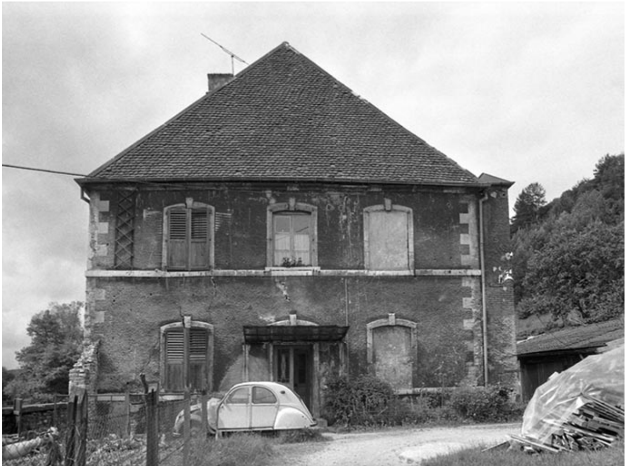
Façade nord du logement patronal en 1980.
