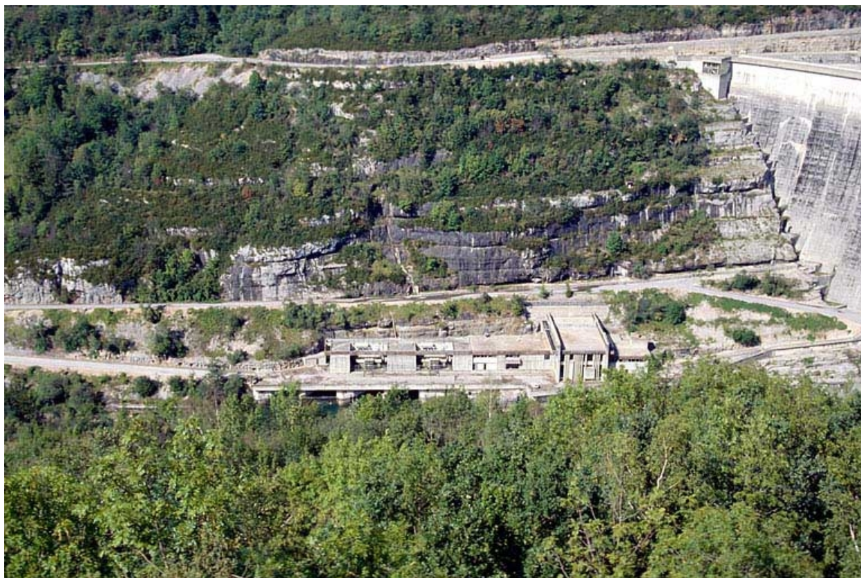
La centrale hydroélectrique.
