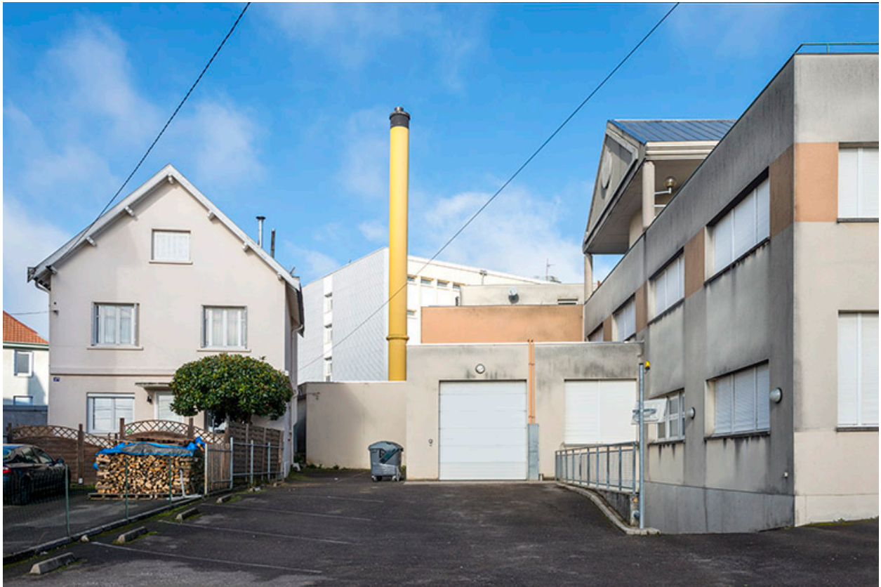
A l'extrémité sud du lycée, la chaufferie.
