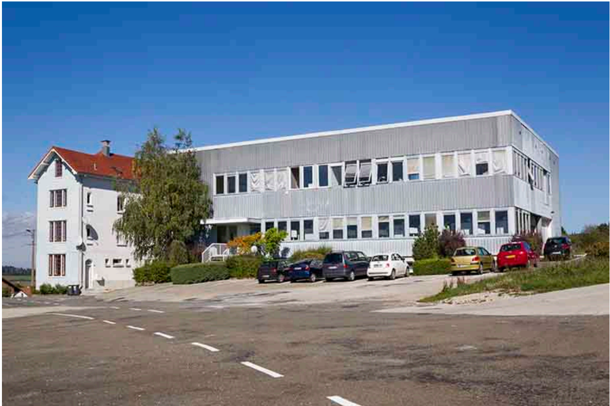
Vue d'ensemble, depuis le sud (atelier de 1948 à gauche, extension de 1970-1971 à droite).
